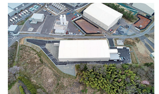
飛灰洗浄処理技術等実証施設
