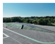
道路盛土の様子
