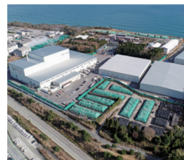
大熊町仮設焼却施設
