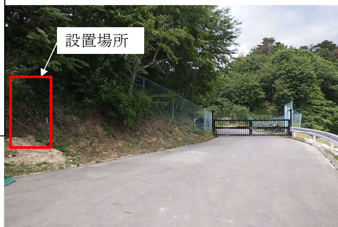
測定機器の設置場所 (埋立地西側門扉付近)
