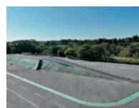
道路盛土の様子
