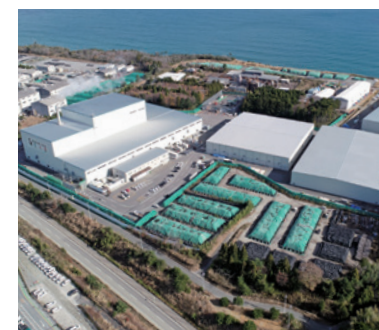
大熊町仮設焼却施設
