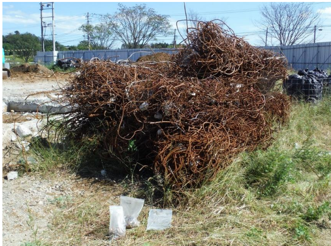
現場に仮置き保管中の金属くず①
