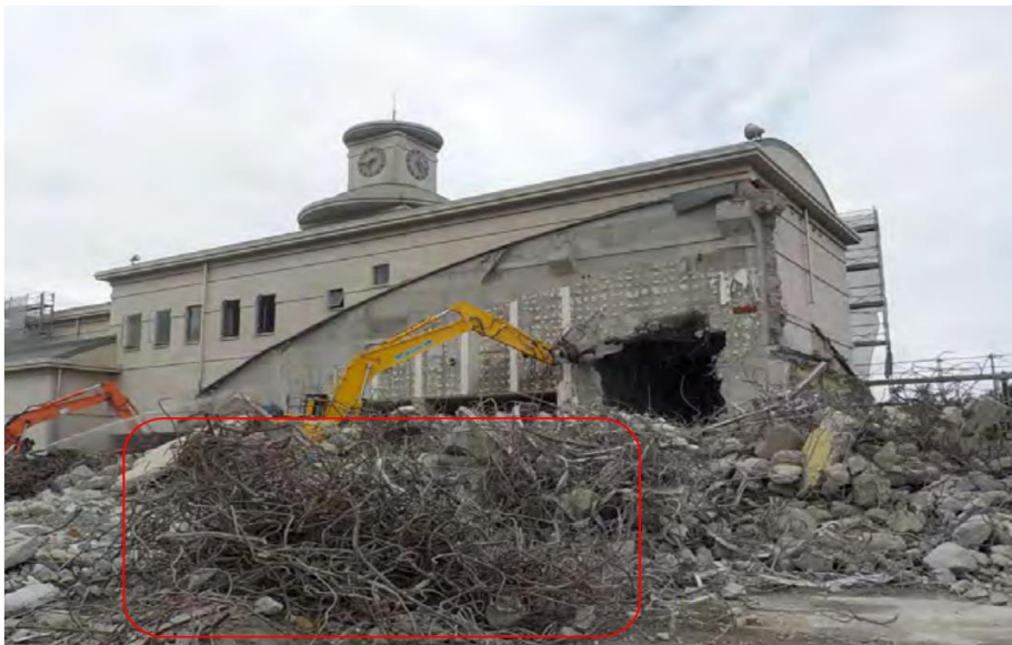
大熊町図書館解体現場状況(2023年5月撮影)
