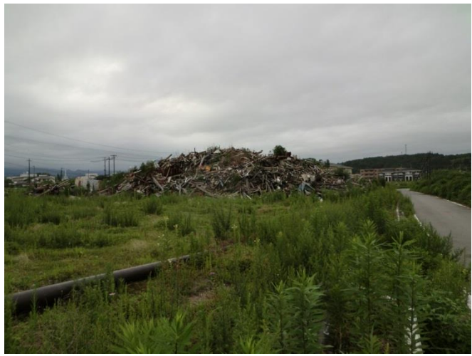
がれき撤去前
