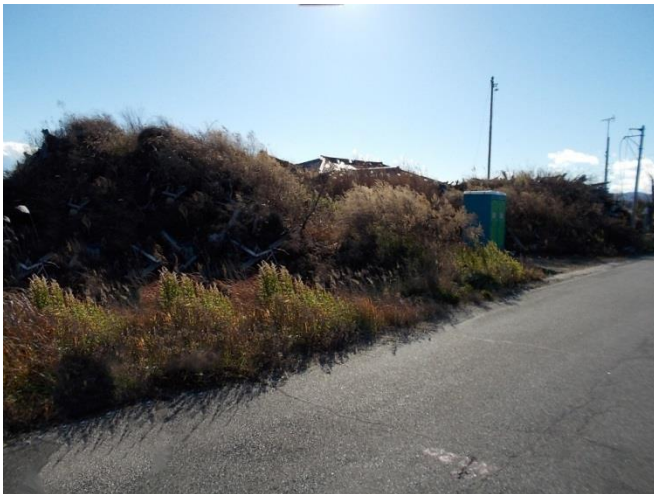
がれき撤去前
