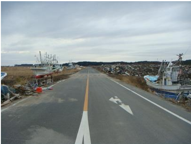
がれき撤去前
